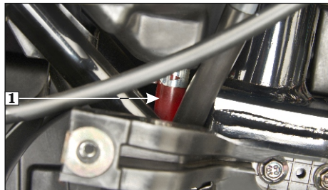
(1) Tubo de drenaje
